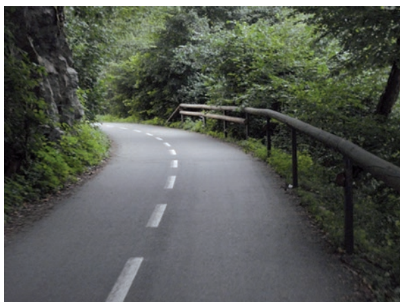
Rys. 35. Drewniane bariery nad zboczem (Bílovice nad Svitavou).
