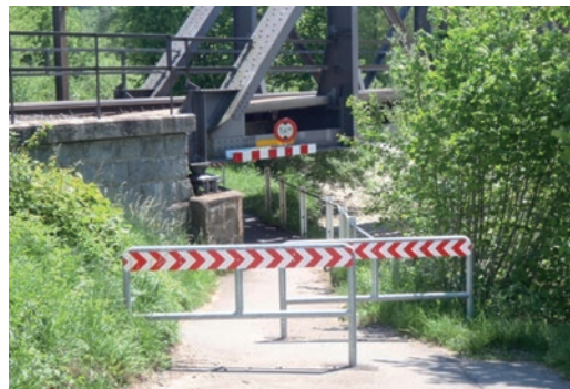
Rys. 34. Bariera ostrzegająca przed zwężeniem i niskim przejazdem pod mostem (Szwajcaria).
