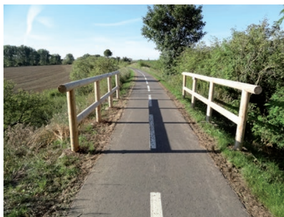
Rys. 36. Balustrada nad przepustem (Nezamyslice)
