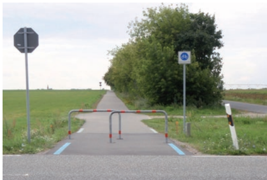
Rys. 33. Bariery użyte przed skrzyżowaniem w celu zwolnienia rolkarzy po zjeździe (Flaeming-Skate).
