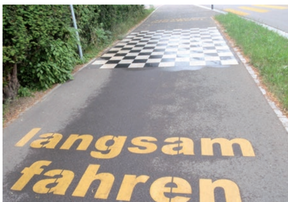
Rys. 31. Ostrzeżenie o zmniejszeniu prędkości za pomocą nawierzchni pomalowanej szorstką farbą (Szwajcaria).
