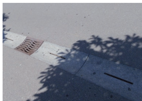
Rys. 28. Nieodpowiednie odwodnienie, służące także jako oddzielenie pieszych od rowerzystów.
