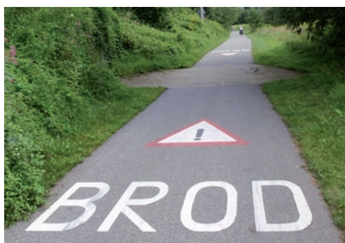
Rys. 27. Oznakowanie poziome ostrzegające przed wodą na drodze (Labská ścieżka).
