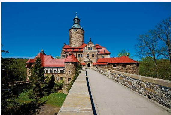
Přístupová cesta ke vstupu
