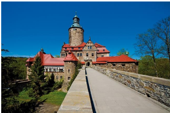
Přístupová cesta ke vstupu
