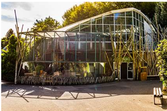
Vstup do pavilónu tropů
