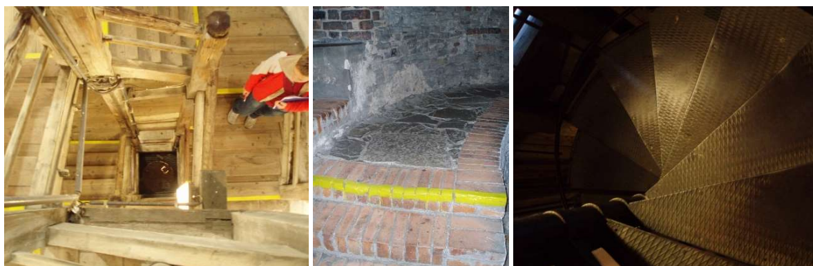
Klatki schodowe wewnątrz wieży Trúba
